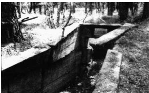
Eingang zum Splitterschutzgraben zwischen Güldensee und Buhrsee (vb 6/2007)
