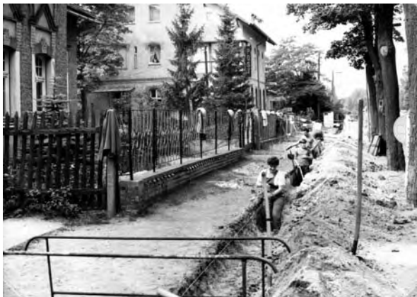
Ausheben der Gräben in der Berliner Straße
