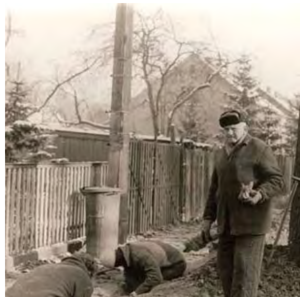
Kurt Brummack bei der Arbeit an der Verkabelung
